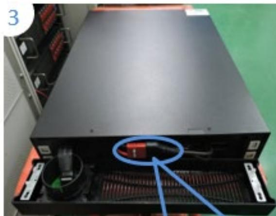
Verriegeln Sie das Batteriekabel
